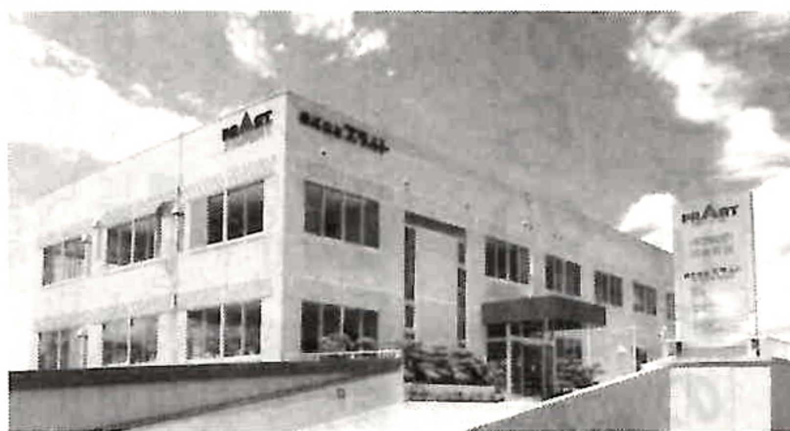
プラルト本社工場
